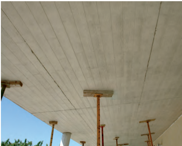
Acabado en hormigón. / EN.Concrete finish. / FR.Finition béton. / DE.Betonbau.
